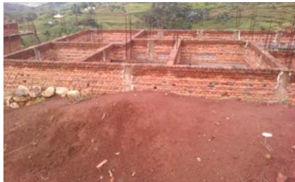
In het kader van versterking van het financieel vermogen van de gemeente Kirinda, is men bezig met de bouw van een winkel annex woning met één etage.
